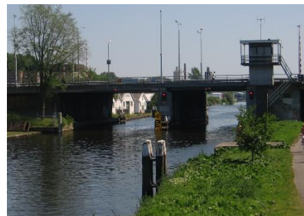
Kruithuisbrug vanaf Delft gezien
